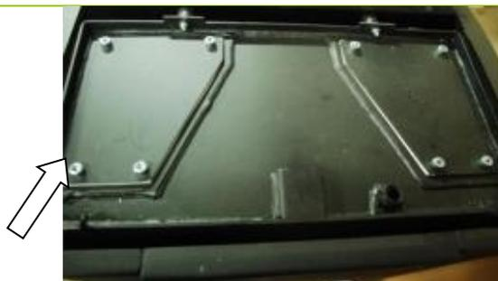
1. Usando pulitore in dotazione della caldaia pulire la cenere depositata sui tubi.
